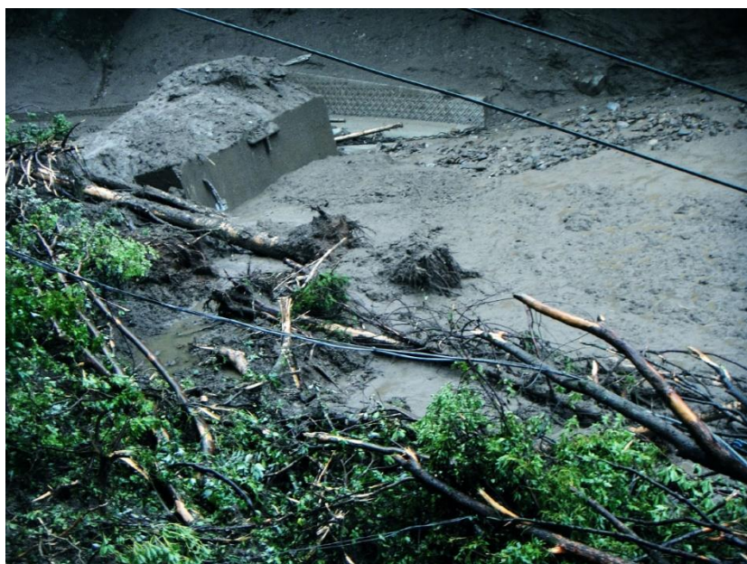
コンクリート三面壁の逢初川と 決壊した砂防ダム 2021 年 7 月 5 日
