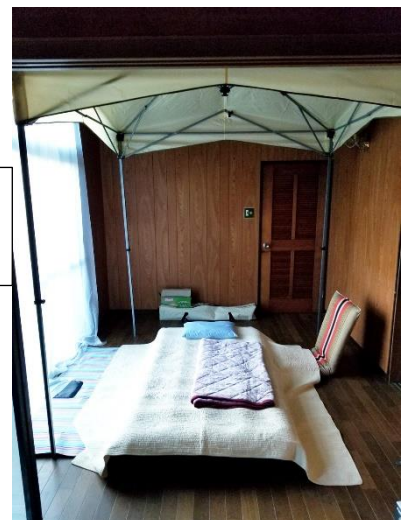
二階が吹き飛ばされた家を修復 南房総布良(めら)
