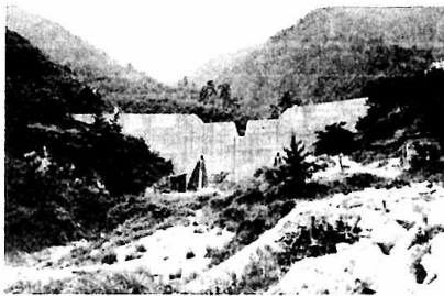
都賀川支流袖谷川 袖谷堰堤 { L=76.0 m H=16.0 m 昭和 29 年 4 月着工、同31年 8 月竣工
